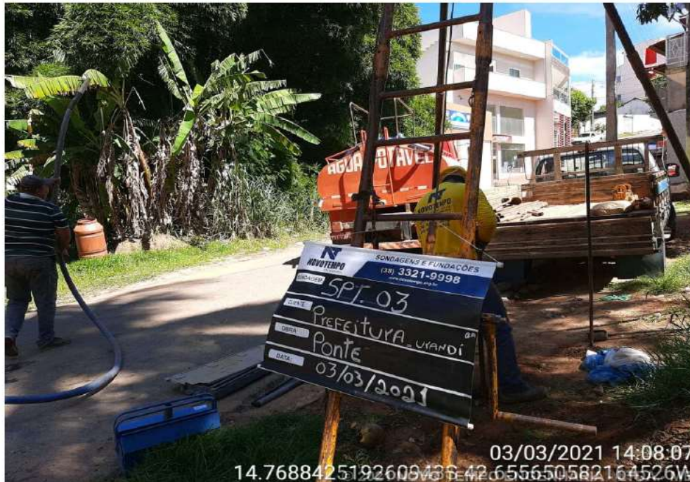
03/03/2021 14:08:07 14.7688425192609436 42.655650582164526W EXECUÇÃO SONDAGEM À PERCUSSÃO SP 03 - URANDI/BA
