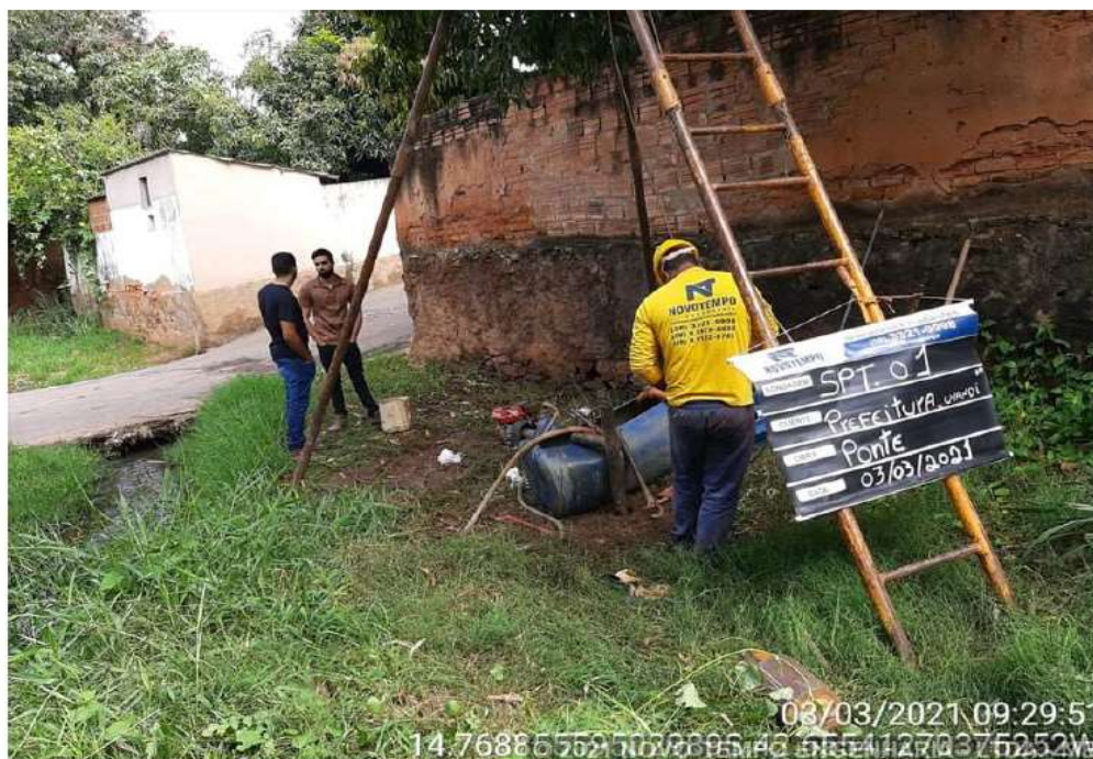
EXECUÇÃO SONDAAGEM À PERCUSSÃO SP 01 - URANDI/BA
