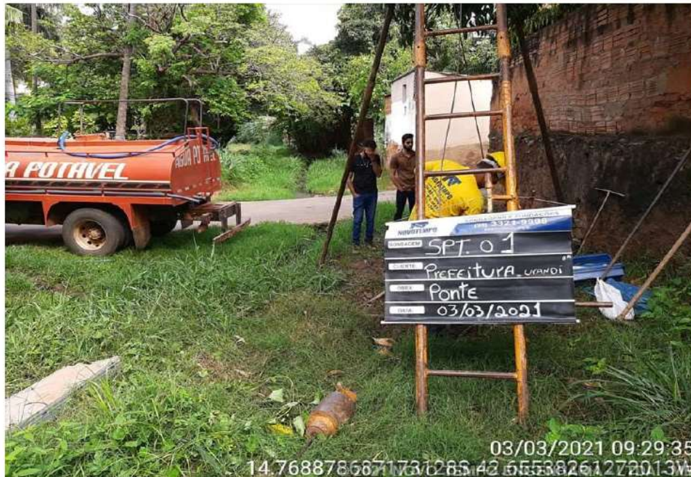
EXECUÇÃO SONDAAGEM À PERCUSSÃO SP 01 - URANDI/BA
